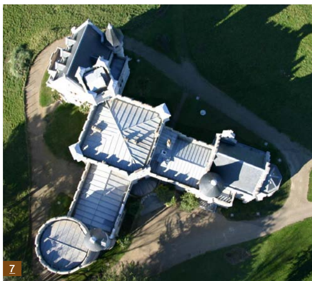
7. Abbadia, couverture majoritairement en zinc. C. Rebière-Balloïde Photo.
