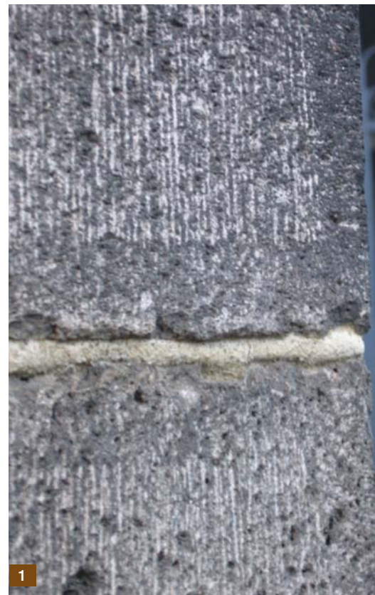
1. Clermont-Ferrand, cathédrale, maçonnerie extérieure du chantier de Viollet-le-Duc, utilisation de la patente et de la ciselure périmétrique, mortier de chaux.
