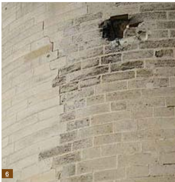
6. Pierrefonds, détail du parement de la tour Charlemagne.
