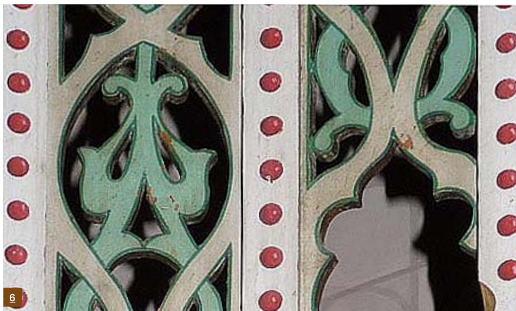
6. Abbadia, escalier en bois peint ajouré avec motifs de boulons.
