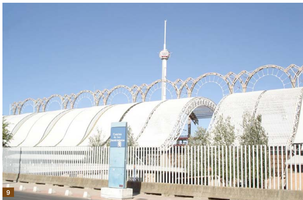
9. Peter Rice, pavillon du Futur de Séville. Détail de blocs de pierre et de fils d'acier, cerclage par post-tension.
