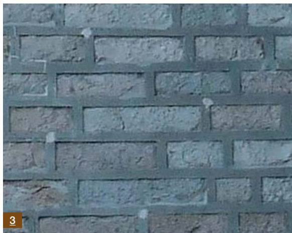
3. Abbadia, appareil polychrome des façades en calcaire de Lasseube.
