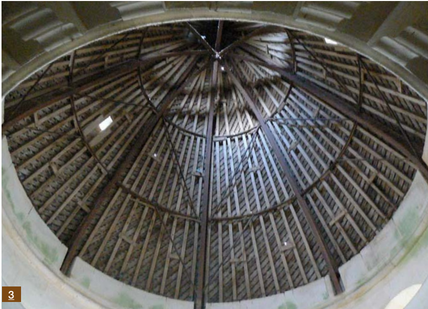
3. Pierrefonds, charpente métallique de la tour Jules-César.
