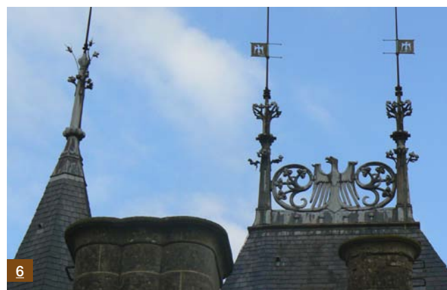
6. Pierrefonds, crête, épis de faîtage, girouettes et paratonnerres de la tour carrée et d'une tourelle.
